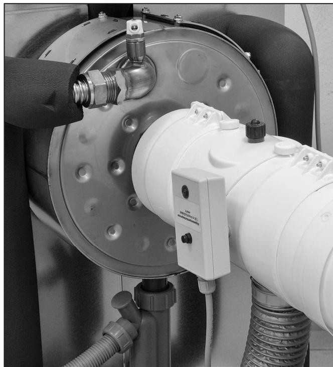
Abb. 15: Montierter Kessel-Anschluss DN80/125 mit Zuluftschauch.
