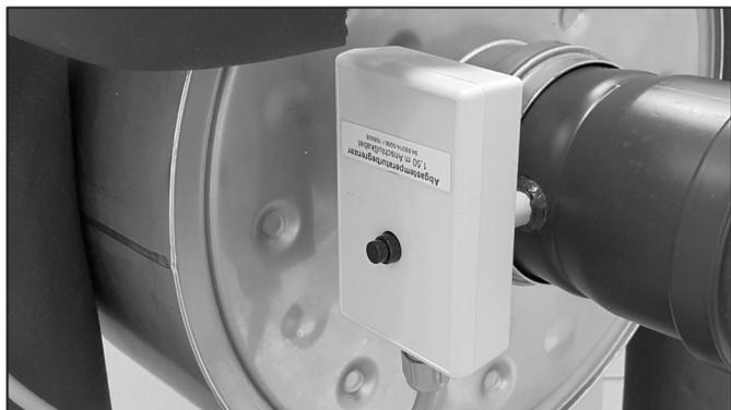
Abb. 88: Position des ATB DN80 (gesteckt)
