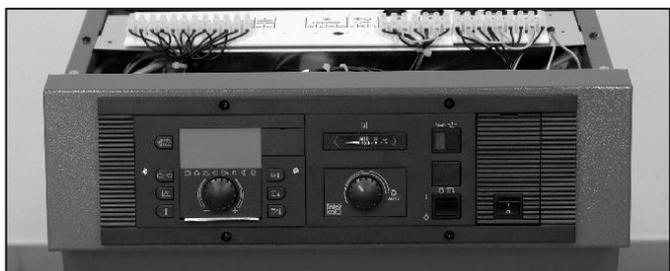
Abb. 32: THETA+ Regelung mit zwei Schrauben befestigen.
