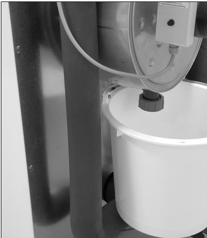
Abb. 85: Eimer unter dem Siphon-Anschluss des Abgaswärmetauschers
