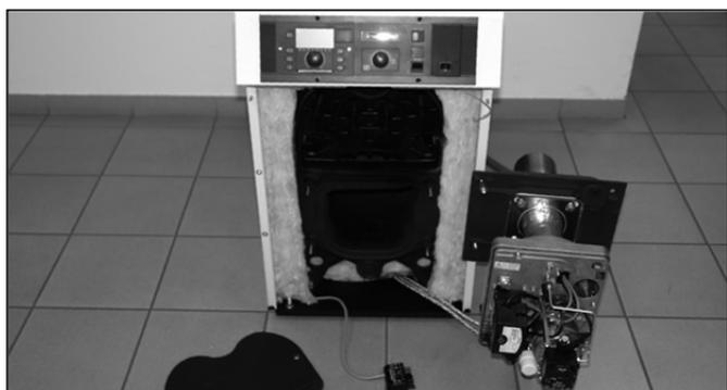
Abb. 83: Geöffneter Kessel mit Brennentür in Wartungsposition
