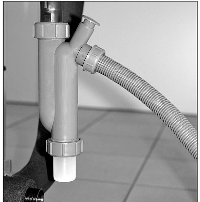
Abb. 80: Siphon und Kondensatschlauch
