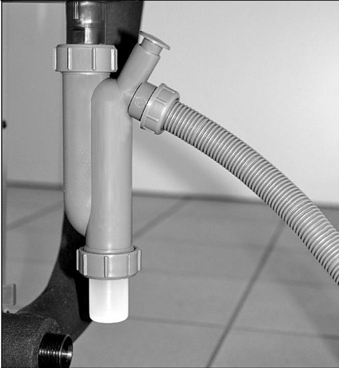
Abb. 23: Montierter Kondensatschlauch am Siphon
