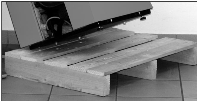
Abb. 6: Montage der KesselfüÙe
