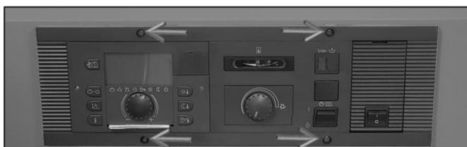
Abb. 35: Befestigungsschrauben des Kesselschaltfeldes
